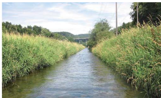
Links: natürlicher Abschnitt an der Sense (FR) mit Bereichen unterschiedlicher Fließgeschwindigkeit und -tiefe (1-4), Kiesbänken (5), Schwemmholz (6), wechselndem Material (7) und einem breiten Ufergürtel (8). Rechts: verbauter, kanalartiger Abschnitt an der Bünz (AG) mit stark reduziertem Lebensraumangebot (gleichförmige Wassertiefe und Fließgeschwindigkeit, konstante Böschungsneigung mit Grasbewuchs und Sträuchern). Quelle: Sonderdruck aus «Wasser Energie Luft» – 103. Jahrgang, 2011, Heft 3 und 4.
