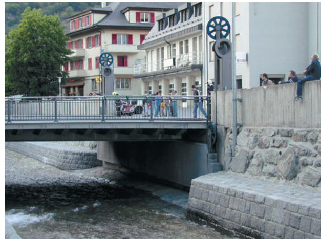
Saltina-Hubbrücke im Normalzustand, nicht hochgezogen
