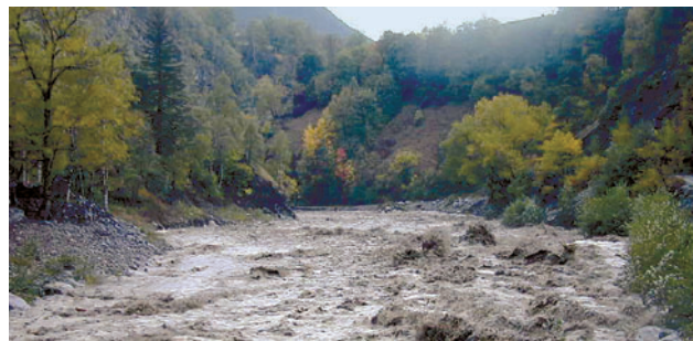
Obere Geschiebekammer im Grindji (Foto in Fließrichtung, Aufnahme vom 14.10.2000)
