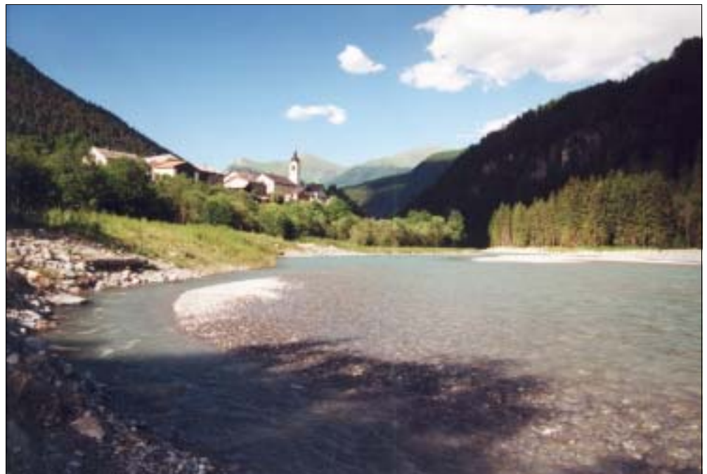
Abbildung 1: Intakte Wassereinzugs- gebiete eine der Voraus- setzungen für einen erfolgreichen Schutz vor Naturgefahren.
