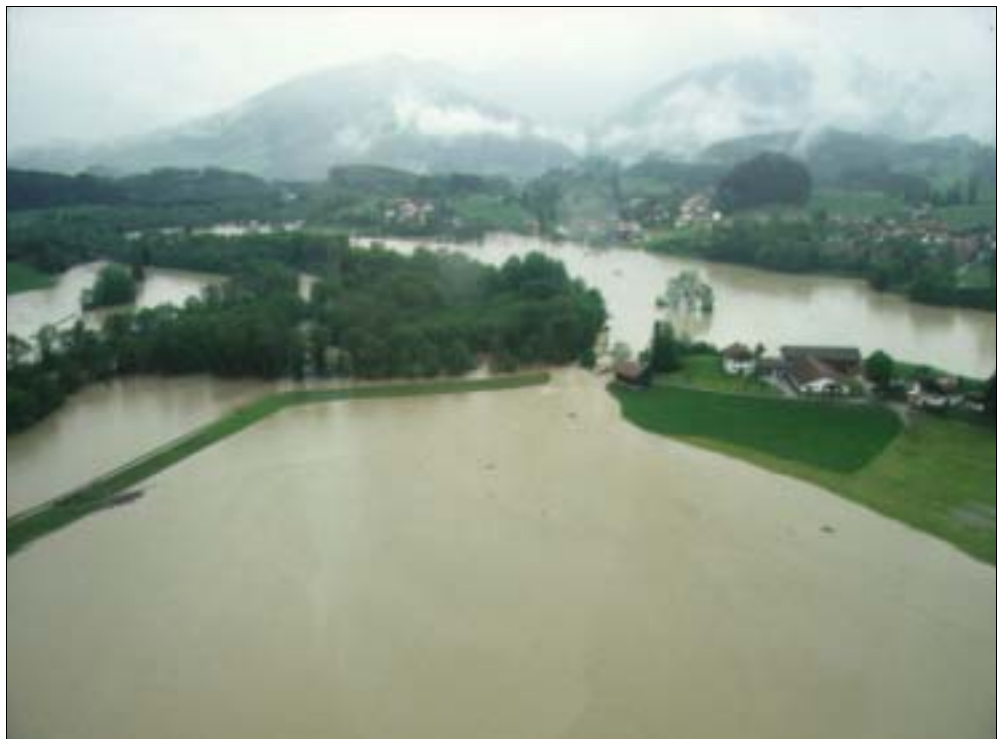
Abbildung 3: Dammbrech bei Flecken am 22.05. 1999. Enge Raumverhältnisse, Zunahme der Bodenversiegelung, extreme Niederschläge und eine nicht risikogerechte Raumnutzung führen immer wieder zu grossen, materiellen Schäden und im schlimmsten Fall auch zu Todesopfern, wenn sich der Fluss oder Bach Raum verschafft.
