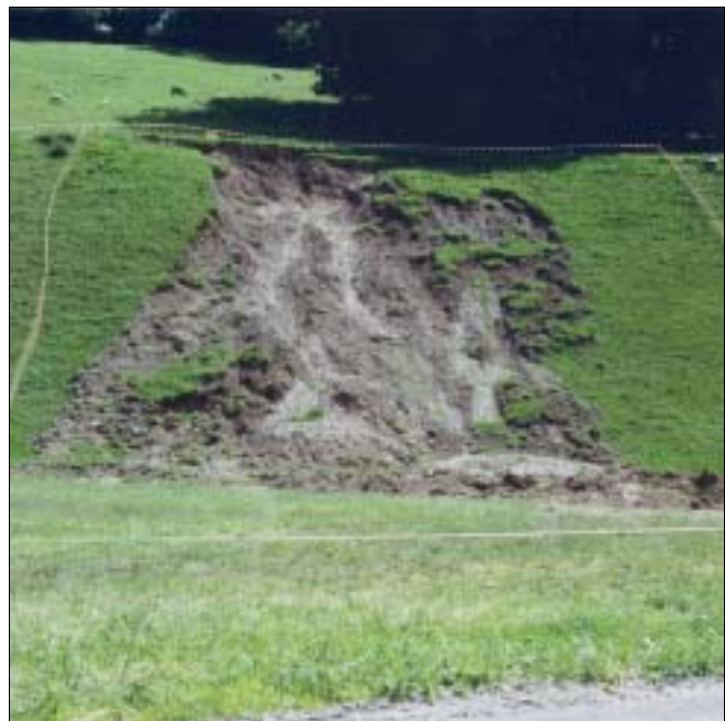
Abbildung 6: Als Folge der intensiven Niederschläge war im hügeligen Gelände eine Beschleunigung der labilen, tiefgründigen Rutschungen zu beobachten. Aus alpwirtschaftlich genutzten Steilhängen lösten sich dabei mehr Hangmuren als aus vergleichbaren, bewaldeten Abhängen..
