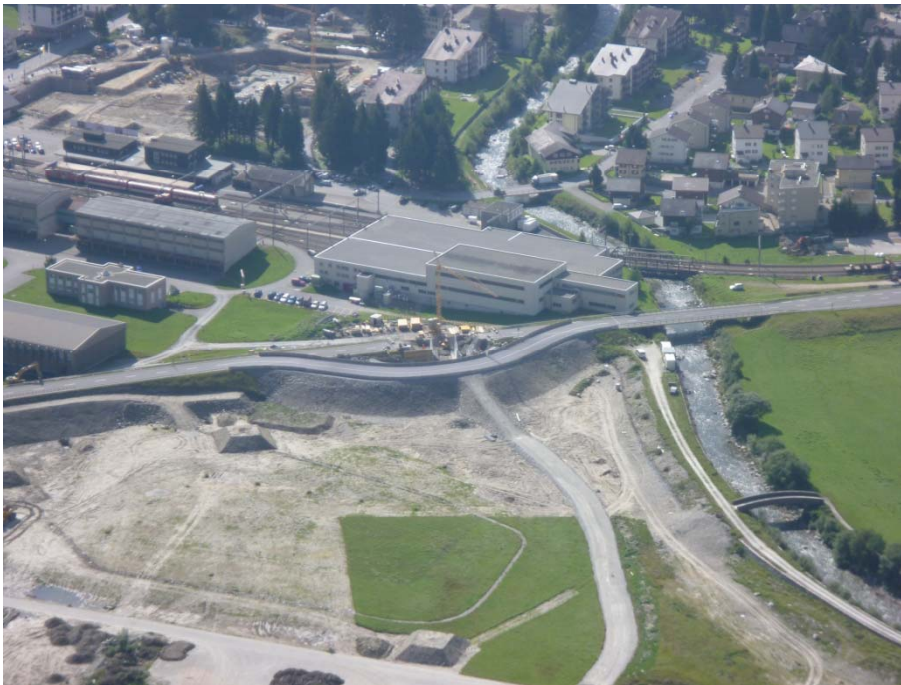
10. Oktober 2010 Erstellung der Abfahr- und Auffahrrampen
