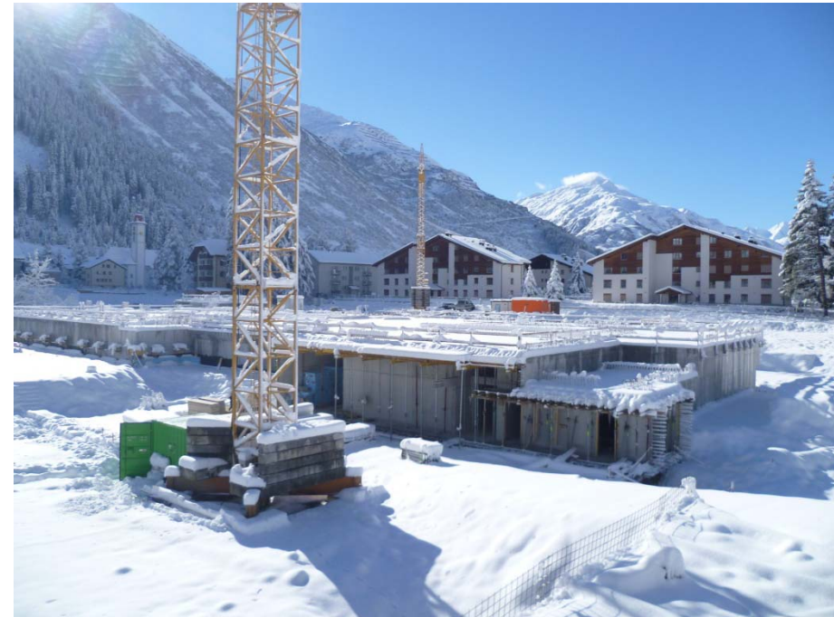
November 2010 Einwinterung, Erdgeschoss überdacht
