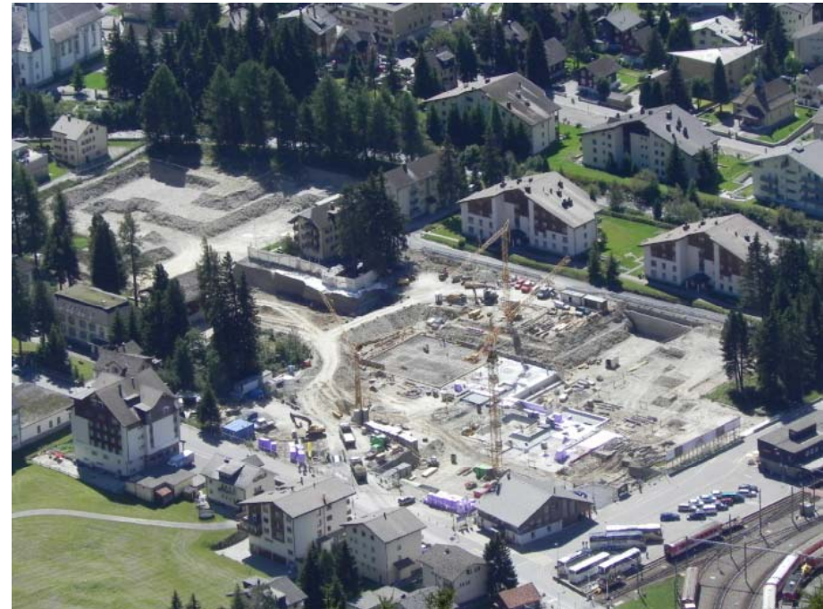
Juli 2010 Installationsarbeiten / Start Rohbau
