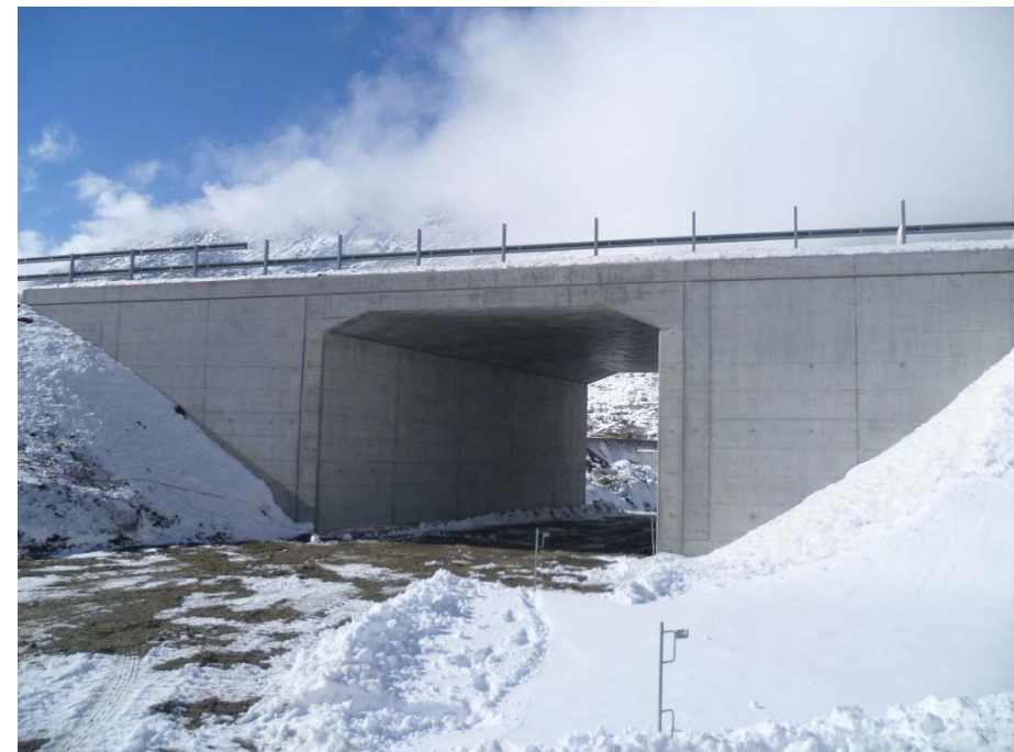
26. Oktober 2010 Unterführung erstellt, Umfahrung abgebaut
