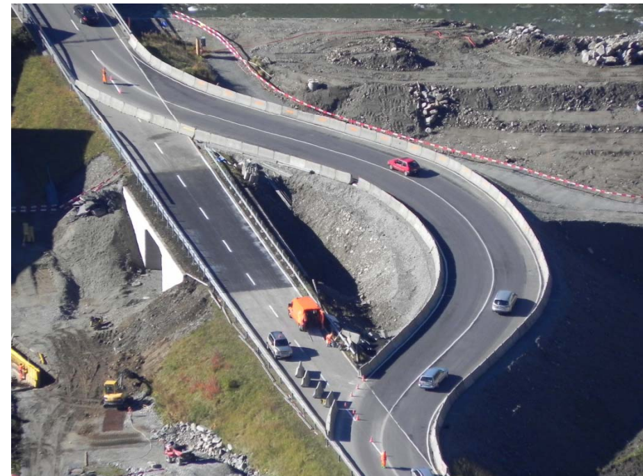
6. Oktober 2010 Bau der Unterführung
