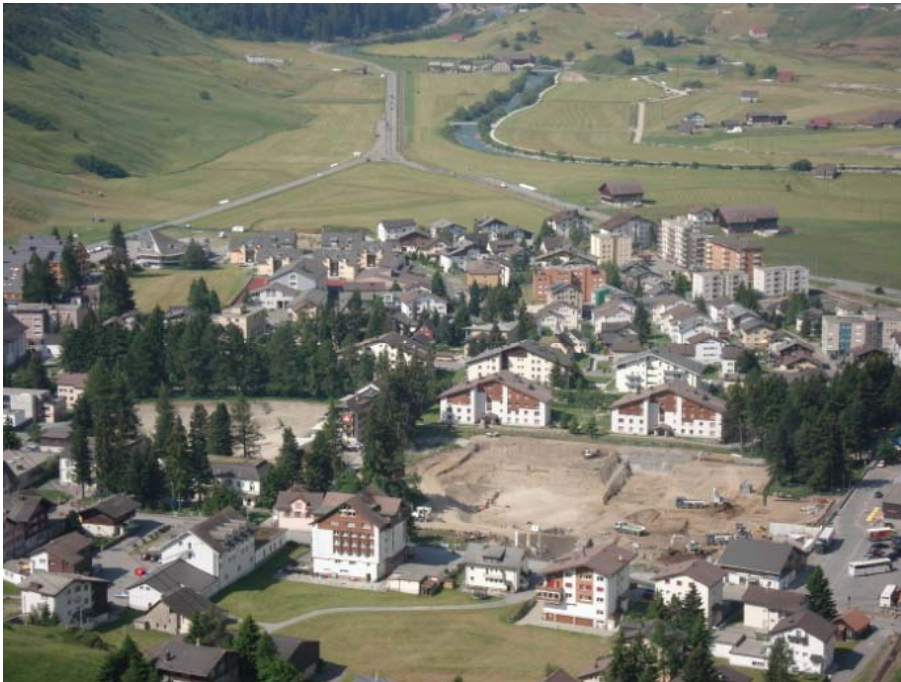
Mai 2010 Beginn Aushubarbeiten
